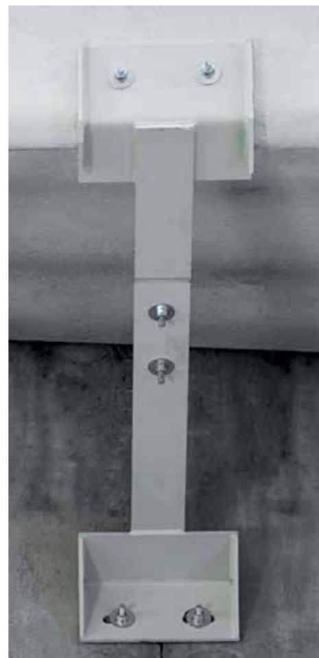
Esempi di sistemi di ritenuta dei pannelli
