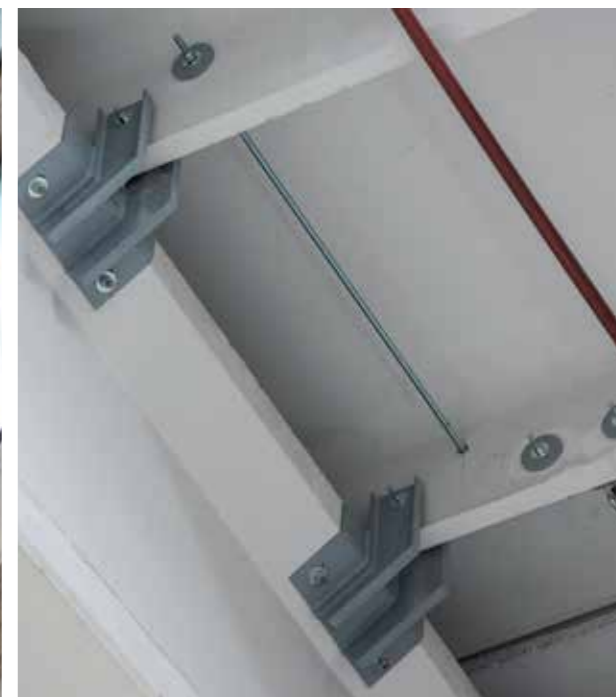
Esempi di sistemi di vincolo tegolo-trave
