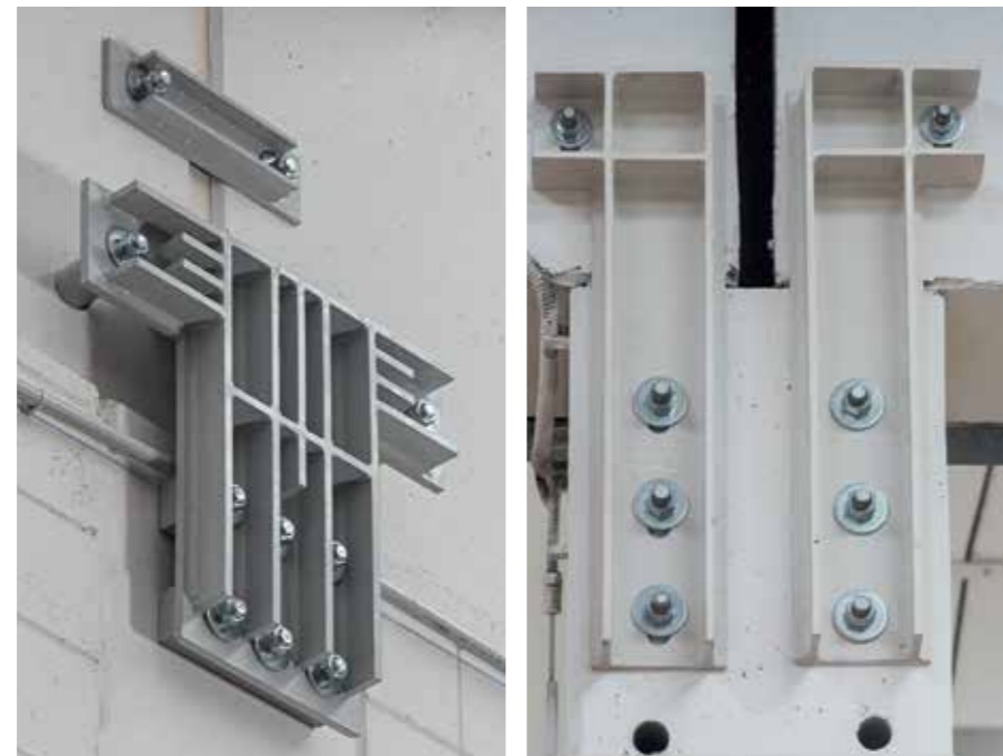
Esempi di sistemi di vincolo trave-pilastro
