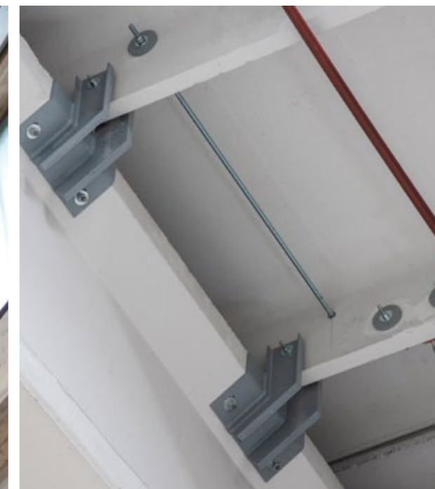
Esempi di sistemi di vincolo tegolo-trave
