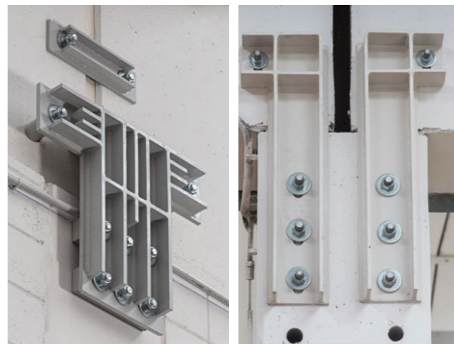
Esempi di sistemi di vincolo trave-pilastro
